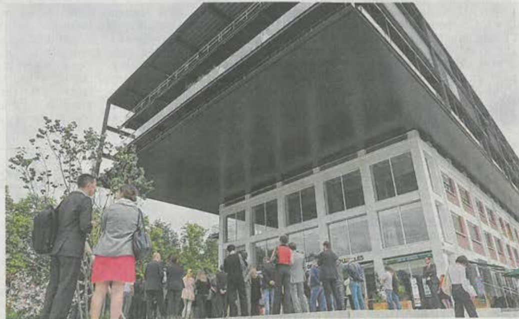
Un porte-à-faux de 15 mètres coiffe le bâtiment tel une casquette. PHOTO DINA - MICHEL FRISON
